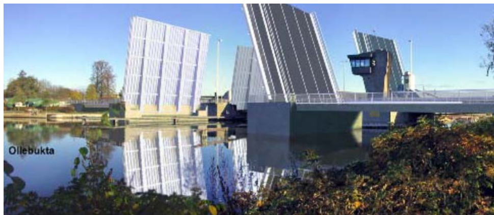
Figur 3.4 Kryssing av Kanalen med klaffebru vest for dagens bru. Kilde: KU 2004
