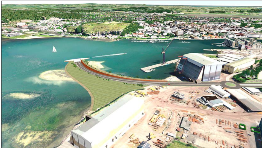
Figur 3.3 Kort tunnel Kaldnes-Korten sett mot Slottsfjellet. Kilde: Statens vegvesen 2015.
