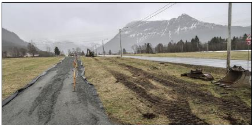
JORDVERN: Knut Hustad meiner at for mykje dyrka jord forsvinn i samband med bygging av gangveg ved Dalane skule.
